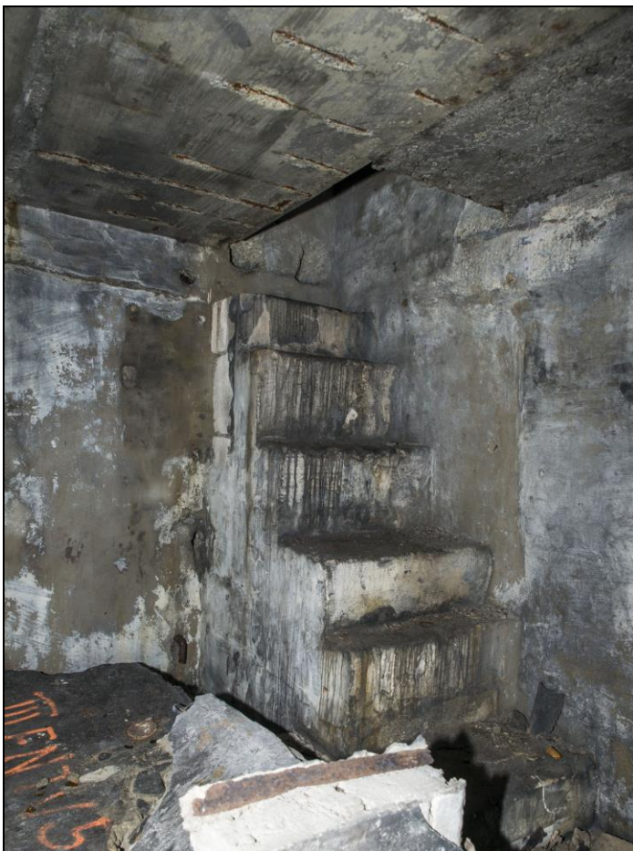
Foto 40 (592). Rohuneeme uuem raketibaas (S-125). Komandopunkt [4]. Trepp teise korruse tupa on väga ebaõnnestunud proportsioonidega, täiskasvanud inimesel on seda ebamugav kasutada. Aga tegemist on tüüplahendusega, selliseid käbikutrepe on teisteski komandopunktides. Foto Mart Mõniste 5.04.2017
