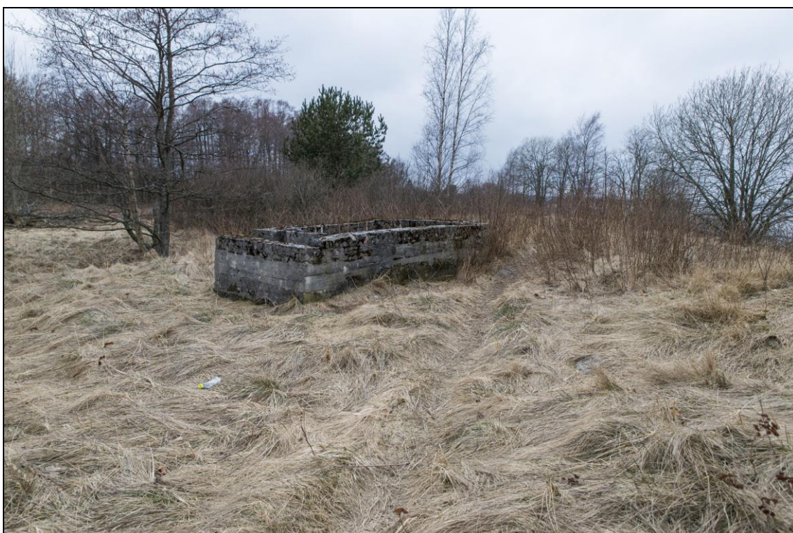
Foto 58 (642). Rohuneeme uuem raketibaas (S-125). Vaatluspunkt [12]. Foto Mart Mõniste 5.04.2017
