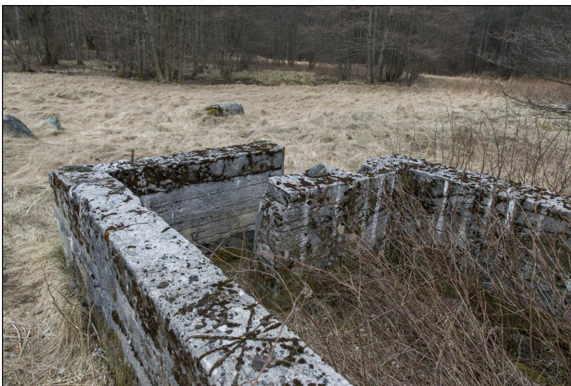
Foto 60 (647). Rohuneeme uuem raketibaas (S-125). Vaatluspunkt [12]. Foto Mart Mõniste 5.04.2017
