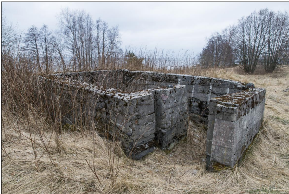
Foto 59 (644). Rohuneeme uuem raketibaas (S-125). Vaatluspunkt [12]. Foto Mart Mõniste 5.04.2017
