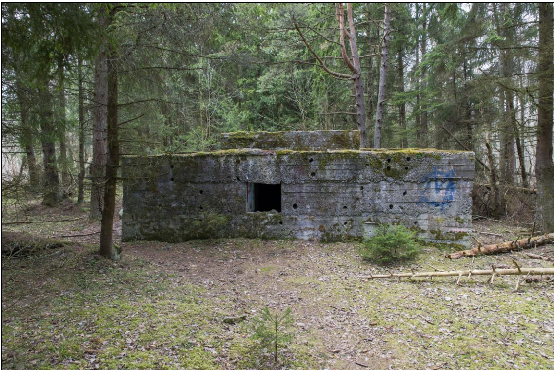
Foto 23 (551). Rohuneeme uuem raketibaas (S-125). Varjend [3]. Sissepääsu varjab massiivne sein, aga selles on ava täpselt uksega kohakuti (!).
